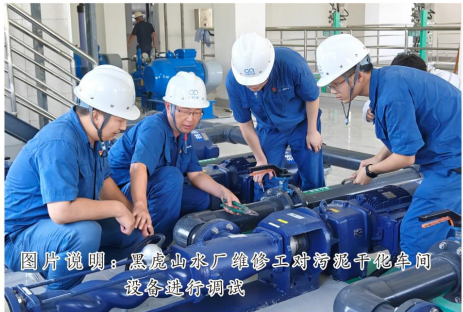
黑虎山水厂污泥干化工程即将迎来竣工
